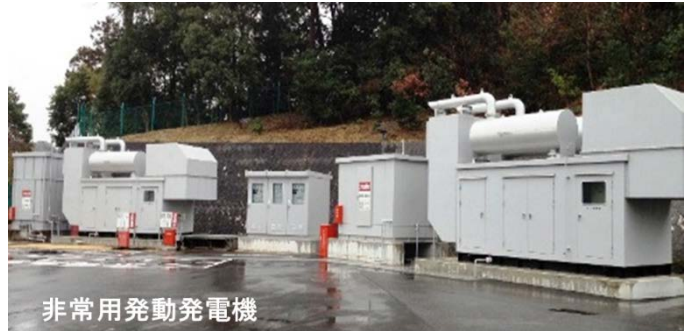
写真：非常用発電機の例
