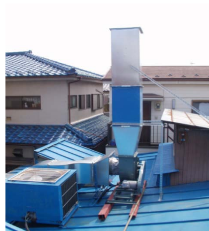
写真4 排出口の高さ、向きの改善の一例
