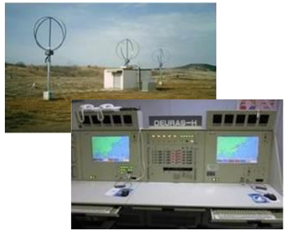
短波監視施設
