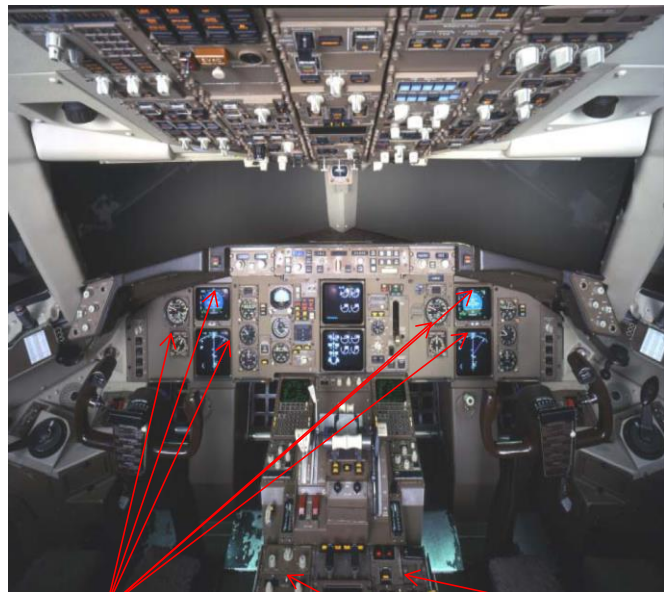
コックピット内の無線設備配置例
