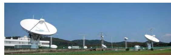
宇宙電波監視施設
