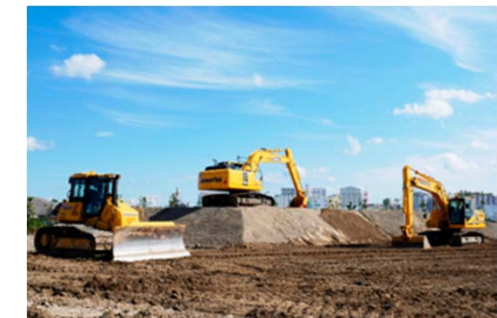
ICT建機が活躍する工事現場
