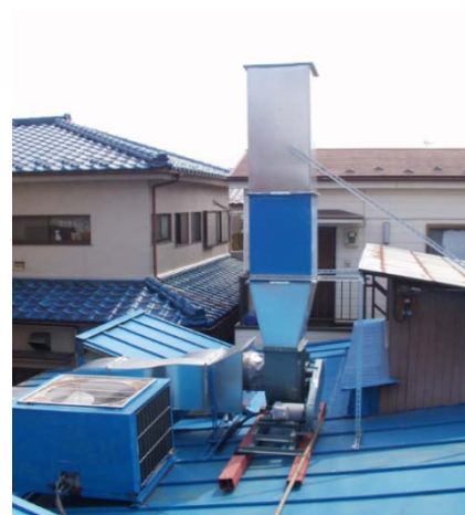
写真4 排出口の高さ、向きの改善の一例
