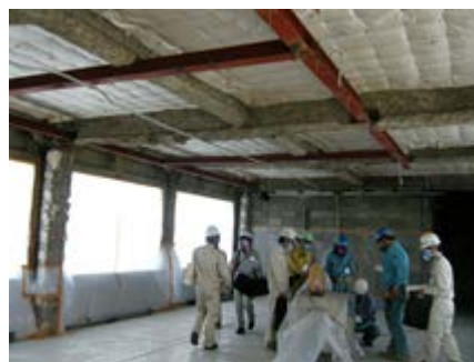
アスベスト除去作業現場の合同立入
