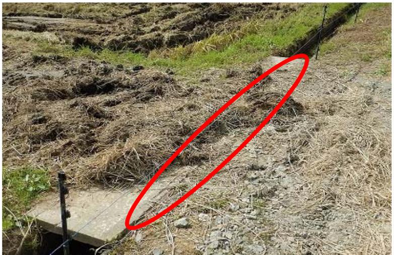
※2段目（最下段）の電線が雑草に隠れて全く見えない状態。
