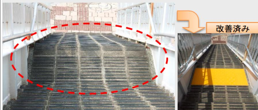
【破損】 踏み板等に腐食により多数の穴が空いている。
