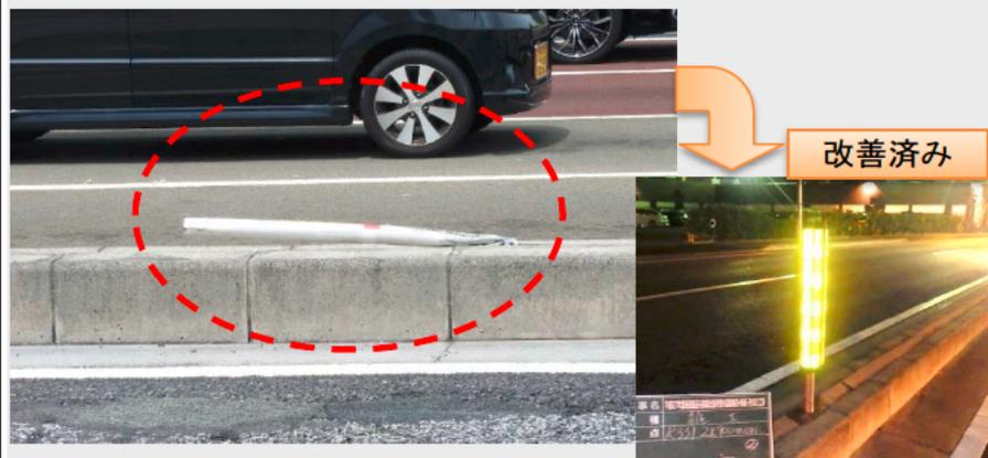
【毀損】 縁石に設置されている複数の誘導標（縁石鋏）が、毀損・脱落し、車両への注意喚起ができていない状態となっている。
