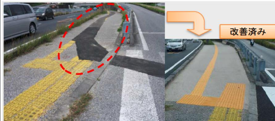
【破損】 視覚障害者誘導用ブロックが複数破損しており、視覚障害者が混乱するおそれがある。
