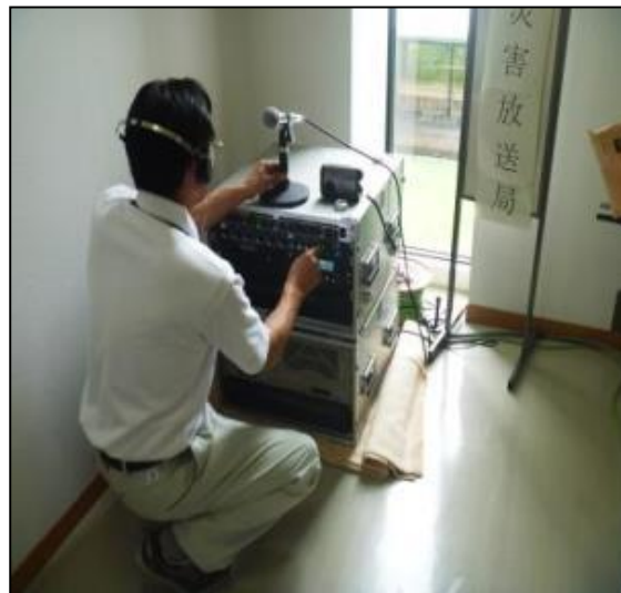
機器調整作業中
