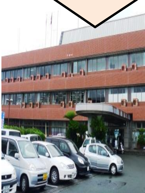
送信アンテナ(屋上)
