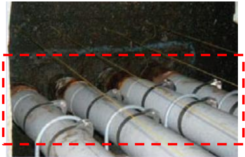
FRP(Fiber Reinforced Plastic)による補修後 軽量かつ高強度の素材で欠けた部分を覆うことで、 施工性と品質を担保
