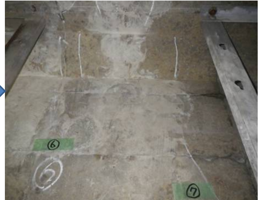
注入工法※による補修後 補修することで漏水を防止
