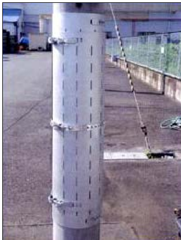
鋼板による電柱補強施工後
