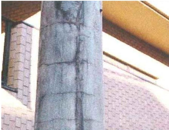
電柱の亀裂
