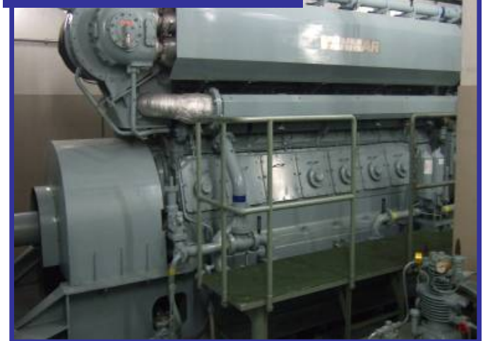
非常用発電装置設置
