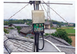
経年劣化したブースター
