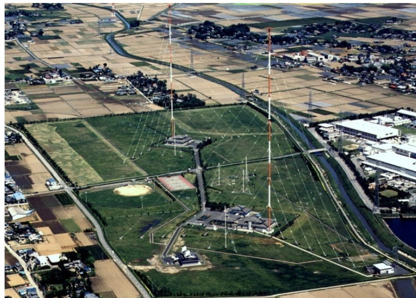
・NHKラジオ第1(写真右): 鉄塔の高さ245m、出力300kW
