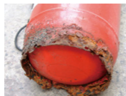
長い間放置され腐食の進んだ消火器
