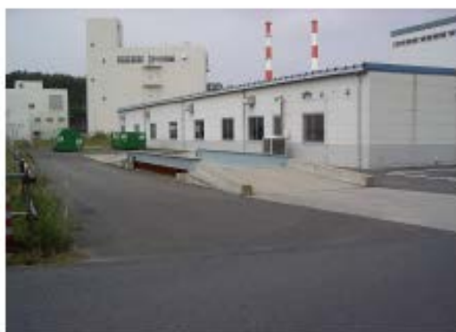
一般器材保管庫の外観
