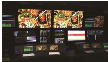
マスターコントロールルーム
