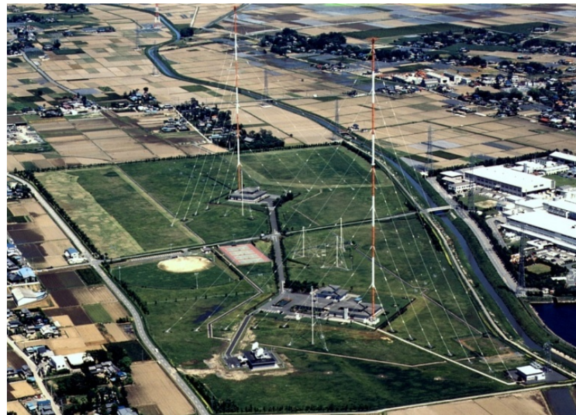
・NHKラジオ第1(写真右): 鉄塔の高さ245m、出力300kW ・NHKラジオ第2(写真左): 鉄塔の高さ215m、出力500kW (所在地: 埼玉県久喜市菖蒲町)
