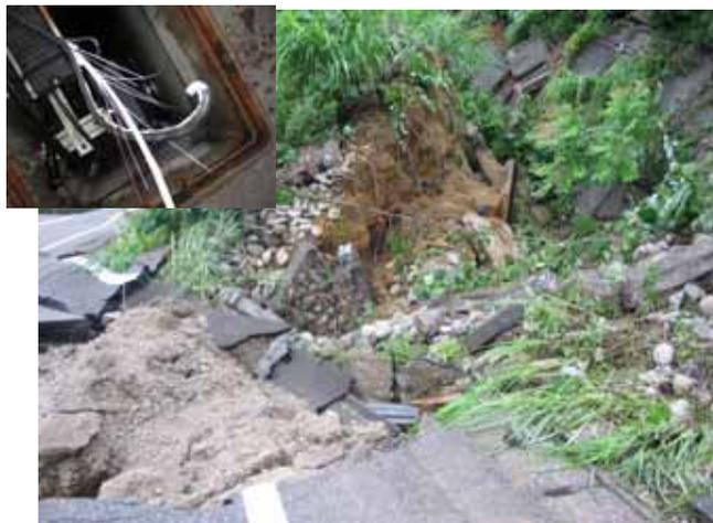
大積千本道路損壊 光ファイバ被災状況
