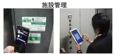
施設管理 東京都の設備点検での空間コードの活用場面
