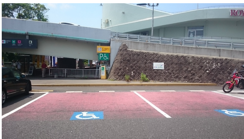
写真3 屋根が設置されていない障害者用駐車場
