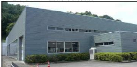
自動車検査・整備等実習棟
