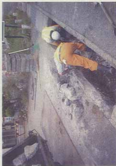
【側溝の補修】
