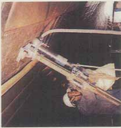
【削孔等による覆工背面の空洞確認】
