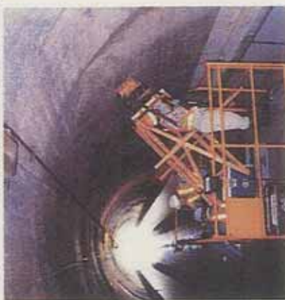
【レーザーによる覆工背面の空洞調査】
