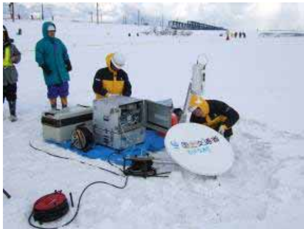
衛星通信装置の設営
