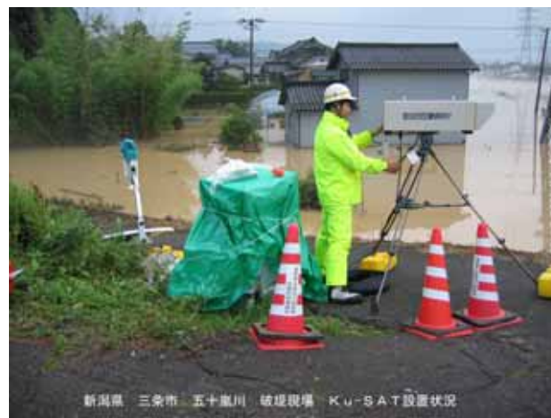
五十嵐川破堤現場
