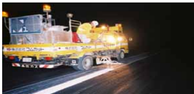
(飛行場標識維持:摩耗部分を復旧するために、標識の塗装を実施)
