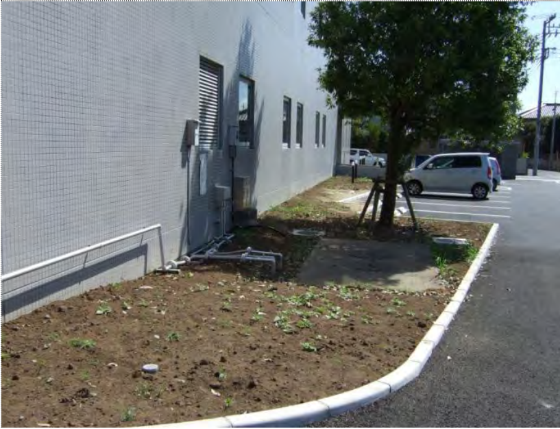
撮影箇所 ⑦
