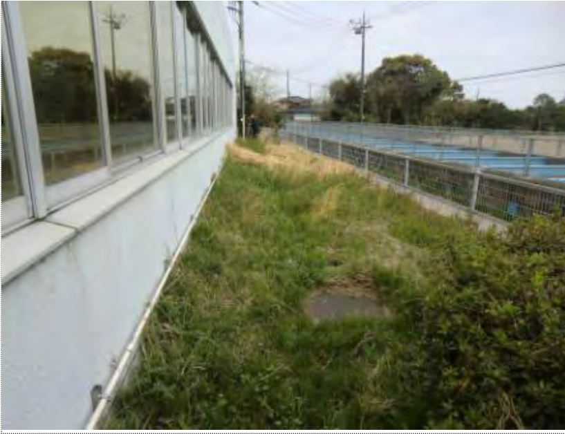
撮影箇所 ⑦
