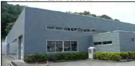
自動車検査・整備等実習棟
