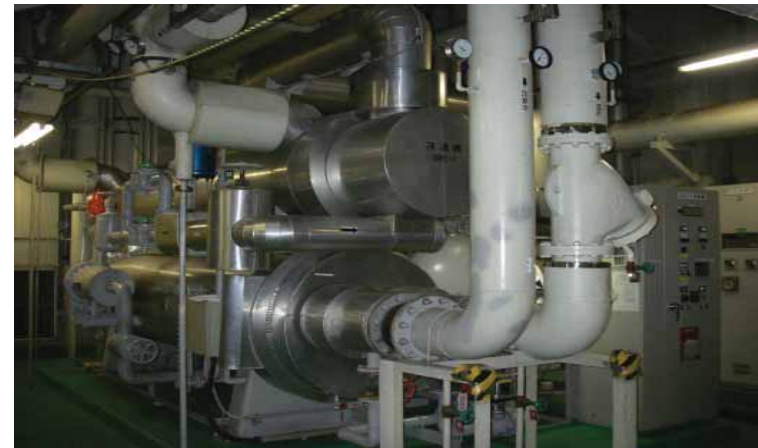
熱回収型水熱源スクルー冷凍機
