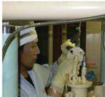
グリーンハウス内全面マスク装備による灰の掻き落とし作業
