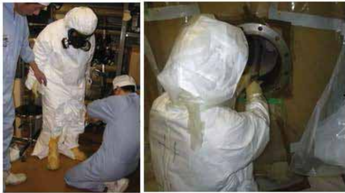
グリーンハウス内全面マスク装備による灰の掻き落とし作業
