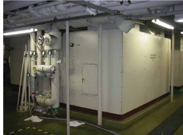
一次空調機(冷暖房機)
