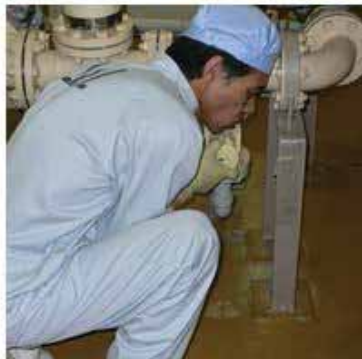
排水処理ポンプの日常メンテナンス及び運転状態点検
