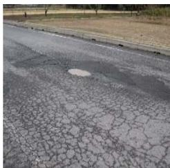
損傷が進み、亀甲状にひび割れが発生している舗装
