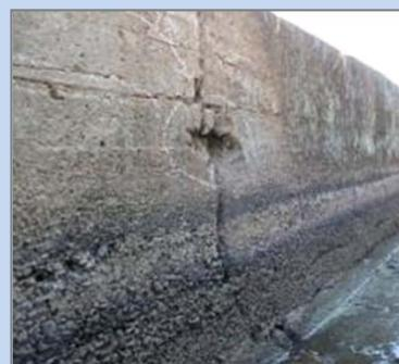
摩耗による骨材の露出
