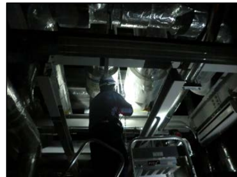
チェーンブロックを用いたバルブ切替操作
