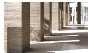
長寿命化 (100年・200年コンクリート)
