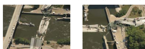
ミネアポリス橋梁の崩壊事故現場
