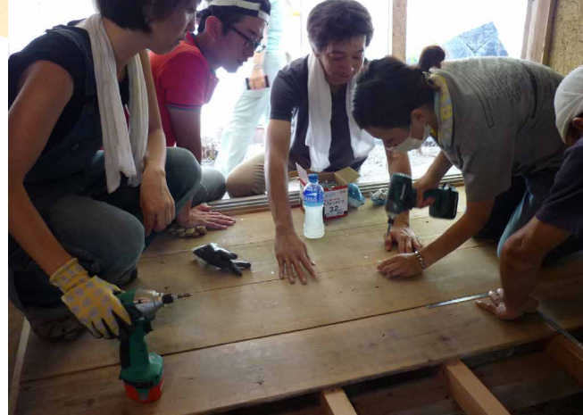
空き家の修繕をイベント化した「空き家リノベーション計画」では近隣の大工さんが指導に当たる。「自分の思うように工事をしてみたい」という本職の参加者もいた。
