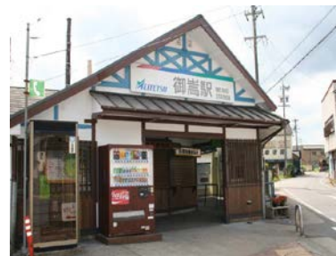
御嵩駅舎修景後(after)
