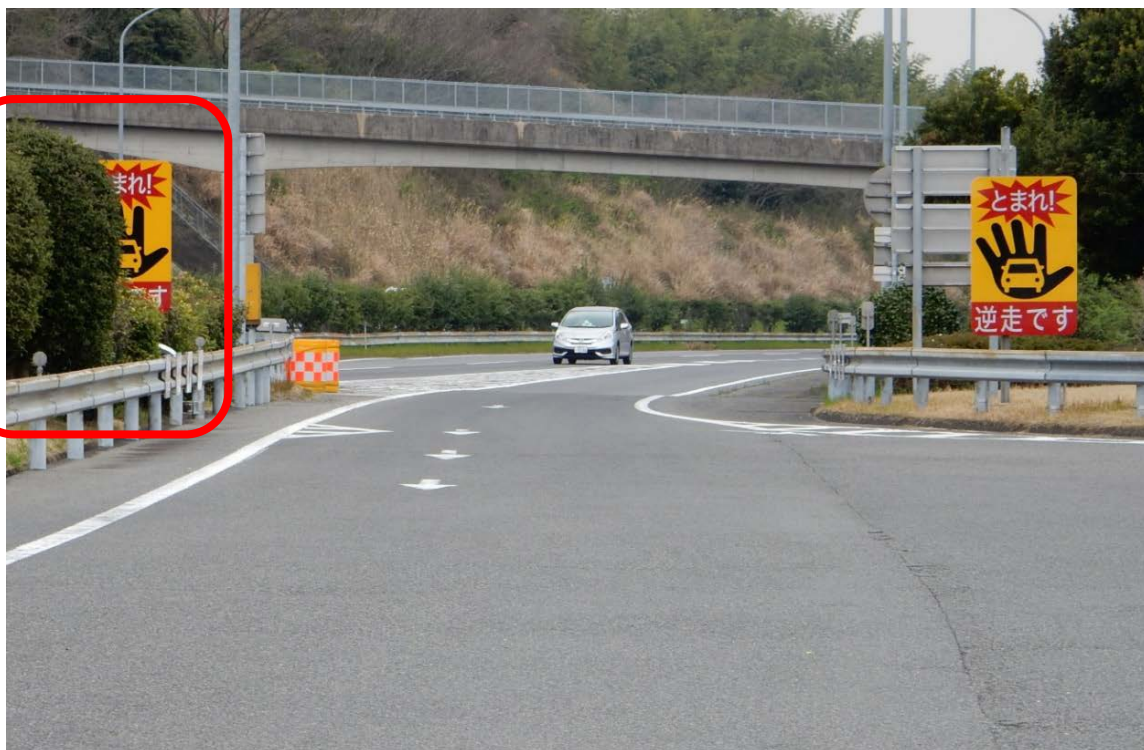
注意喚起看板が樹木で隠れている
