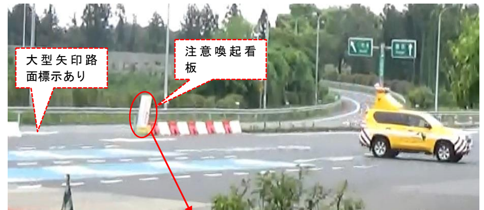
大型矢印路面標示と注意喚起看板を設置(常磐道水戸IC)
