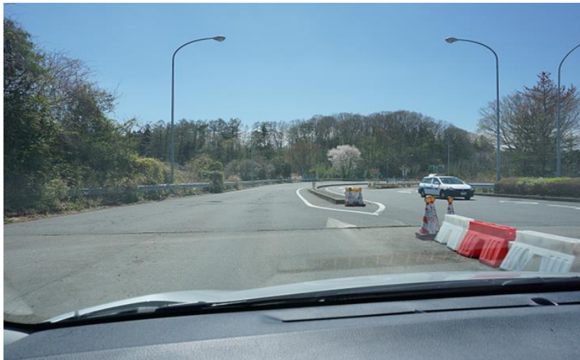
大型矢印路面標示以外の注意喚起がない(関越道赤城IC)
