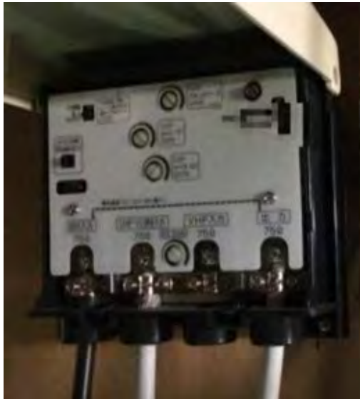
図 3. 6-15 旧式機器『直付け型機器』
