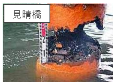
鋼鉄製の支柱の腐食
