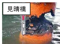
鋼鉄製の支柱の腐食
