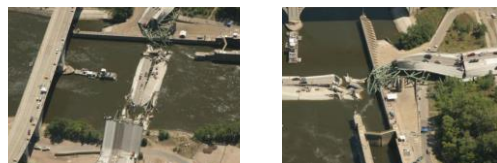
ミネアポリス橋梁の崩壊事故現場
