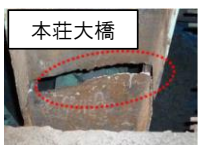
トラス橋の斜材の破断
