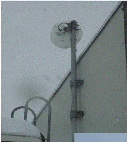
ポールマウント方式 設置例
