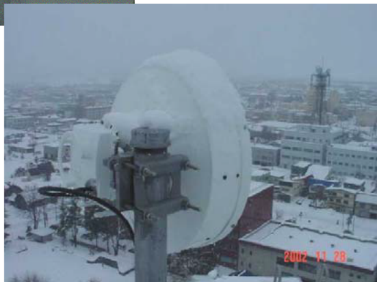
滝川市役所屋上
