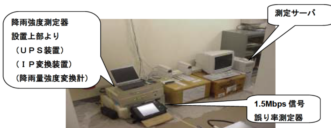
図5 測定機材 設置状況
