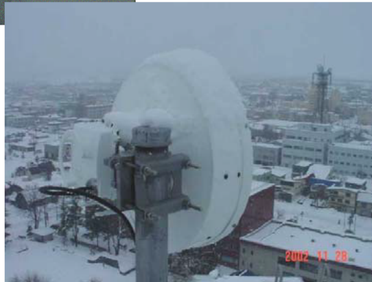
滝川市役所屋上
