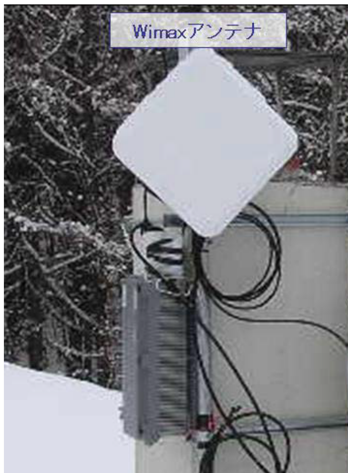
屋外設備(屋上)
