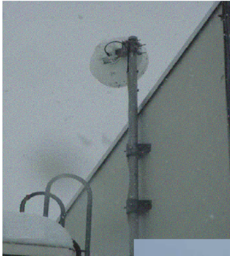
ポールマウント方式 設置例
