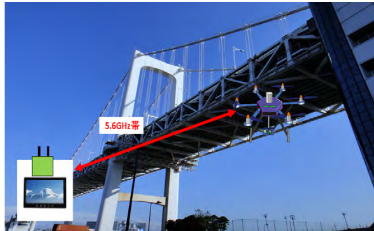
図 3.3.3-3 ドローン等によるインフラ点検イメージ
