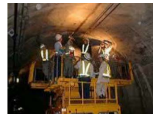
トンネル天井付近の保守作業
