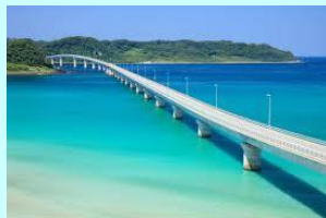
角島大橋(下関市)
