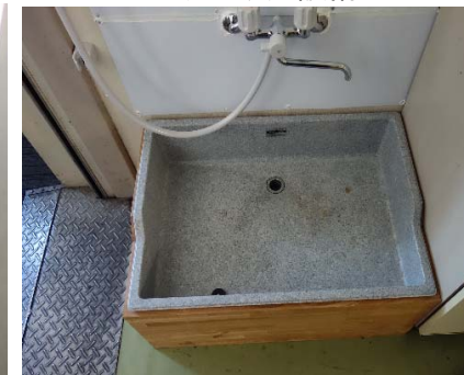
ウドゥ用設備
