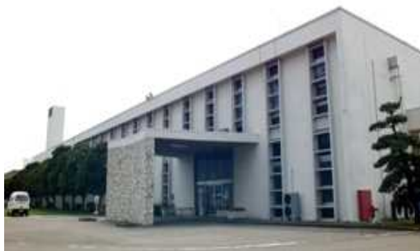
プルトニウム燃料第一開発室外観
