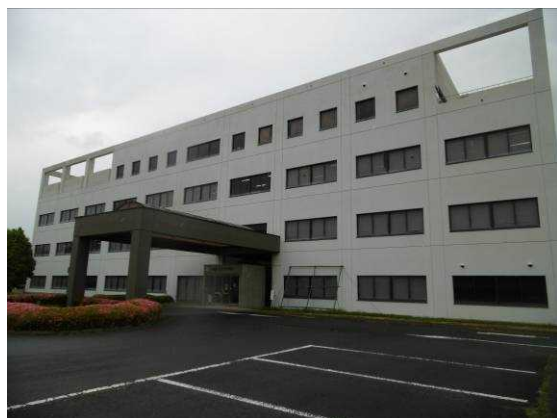
エントリー外観
