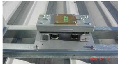
図-18 振動筋の固体伝搬音低減
