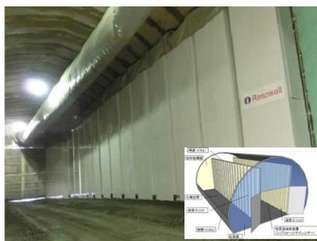
図-5 空間の共鳴を利用したトンネル発破時の低周波音低減（主に 16~63 Hz の発破音を吸音、低減）<sup>7)</sup>
