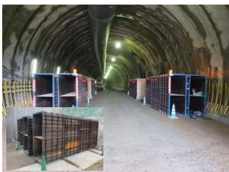
図-4 音響管を利用したトンネル発破時の低周波音低減（主に 16~20 Hz 帯域の発破音を吸音、低減）<sup>6)</sup>
