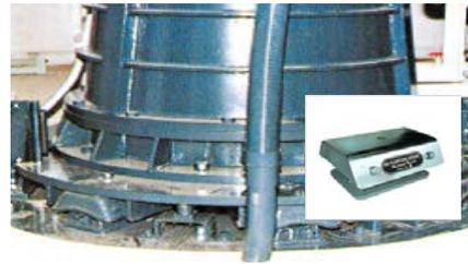
図-17 縦型ポンプの固体伝搬音低減
