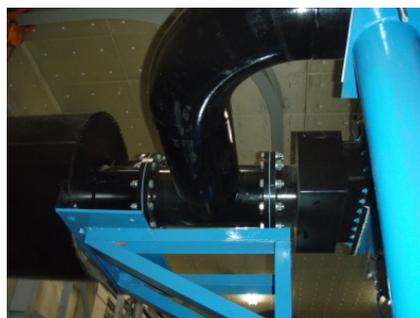
往復式空気圧縮機吸気管の手前配管からブランチ管を分岐
