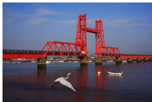
筑後川昇開橋
