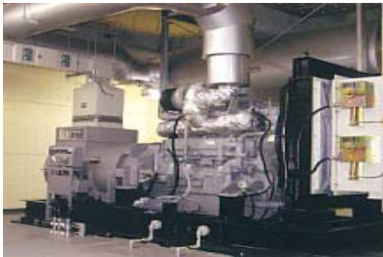
非常用発電機
