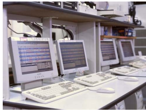
運用監視装置
