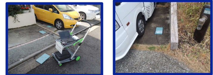
水道メータ設置の特殊環境例
